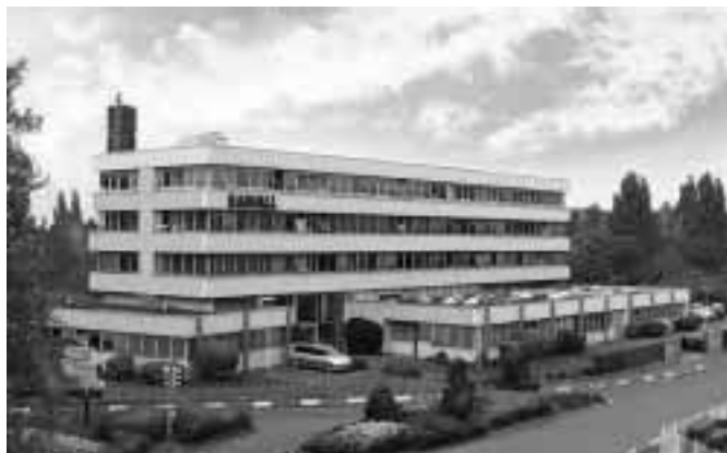
Head Office - Rosny sous Bois
